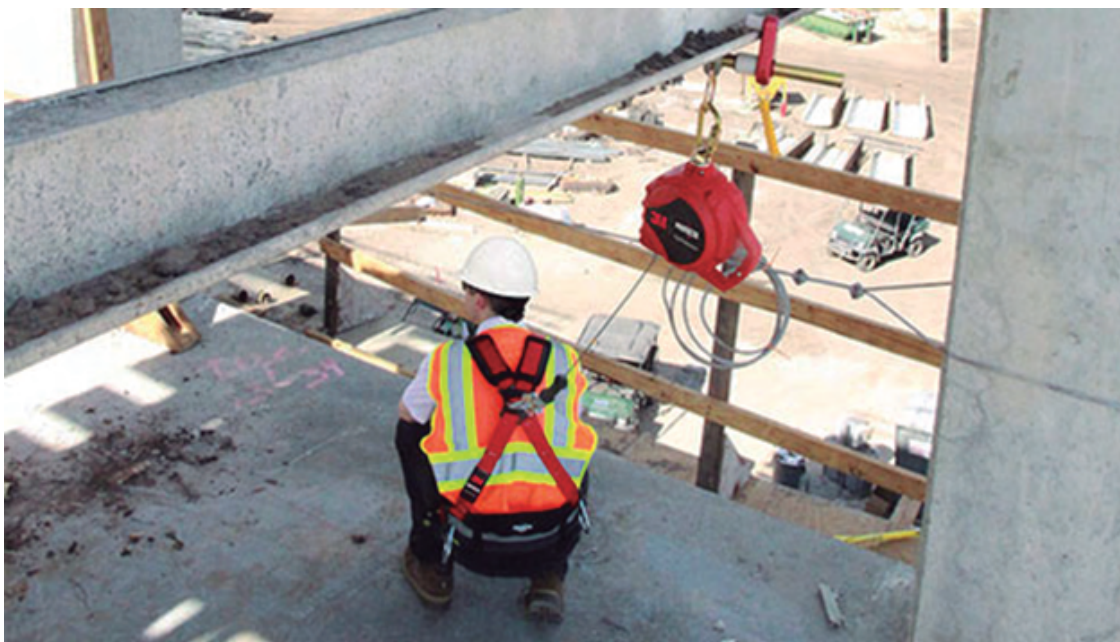
Figura 19 Exemplo de utilização de trava queda retrátil no canteiro de obra. Fonte: https://www.engineeredfallprotection.com/srl-self-retracting-lifelines
