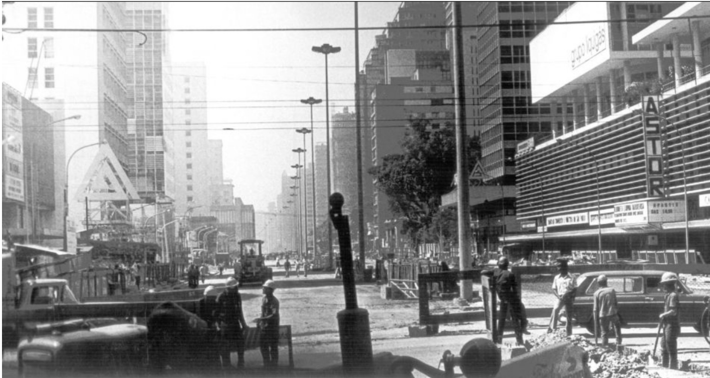
Avenida Paulista em obras -1972
