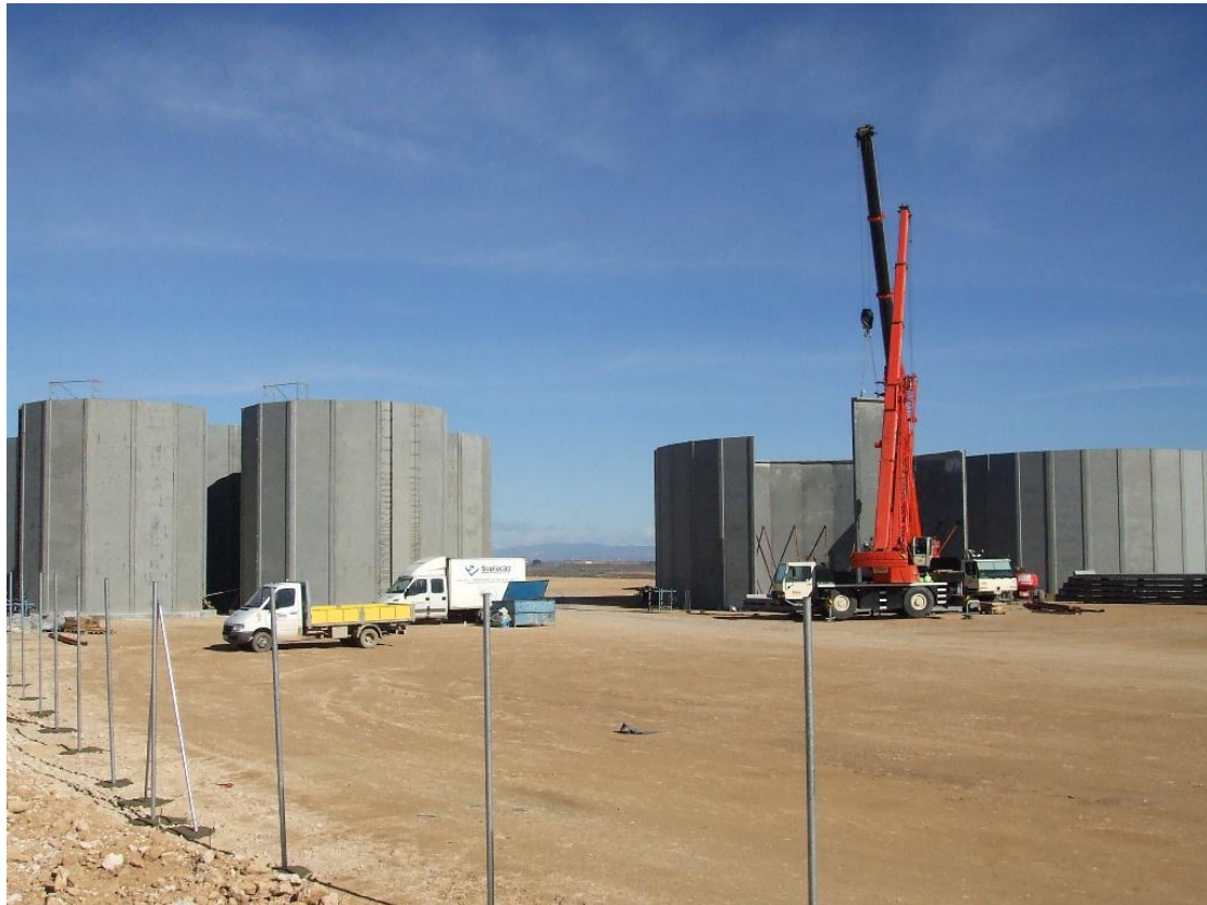
Montagem de tanques em obras de Biogás
