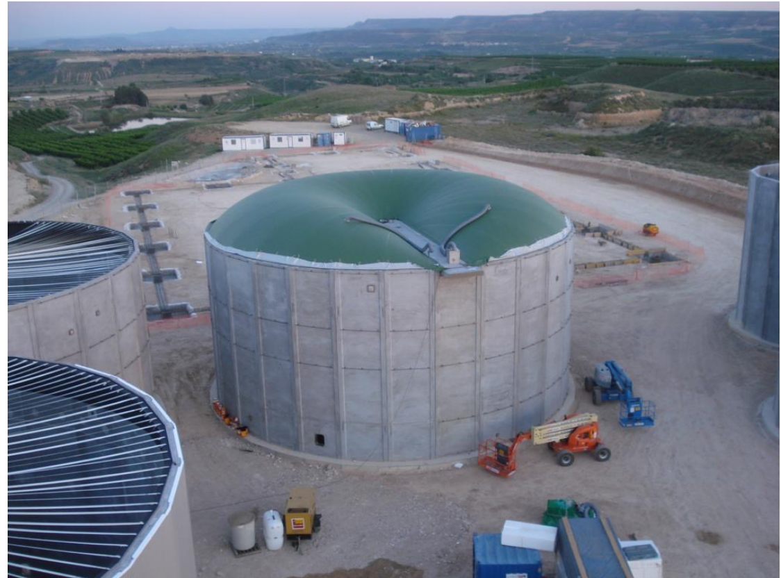
Tanques em obras de Biogás
