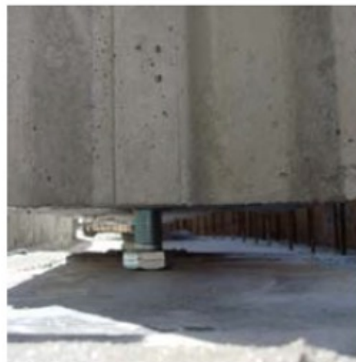
Parafusos de nivelamento na base dos painéis
