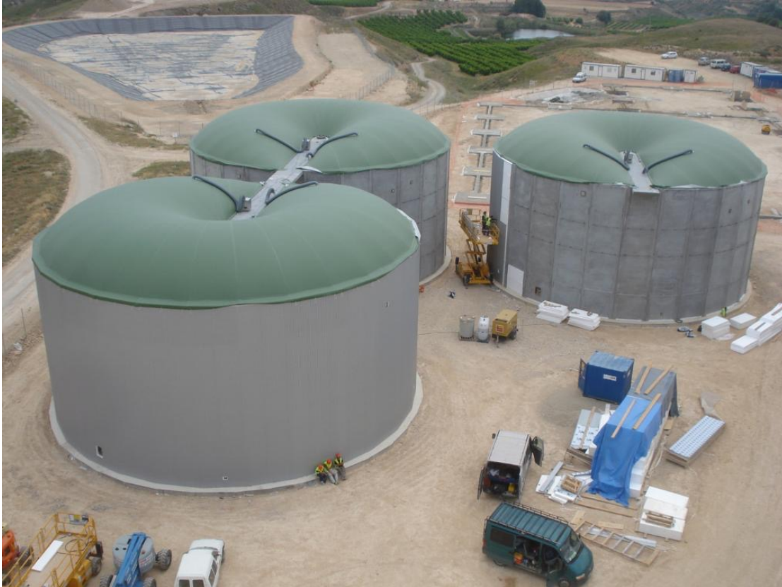
Tanques em obras de Biogás
