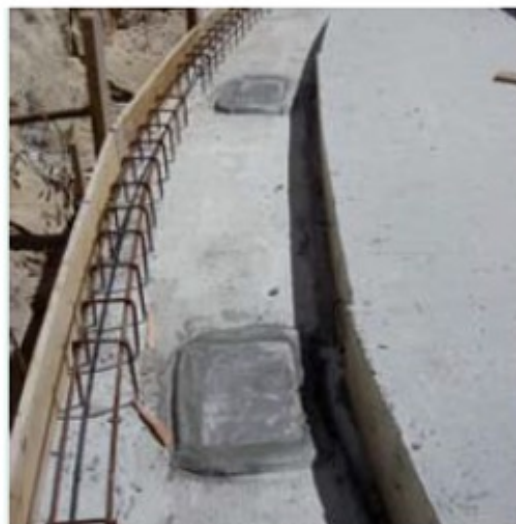
Placas para nivelamento de painéis
