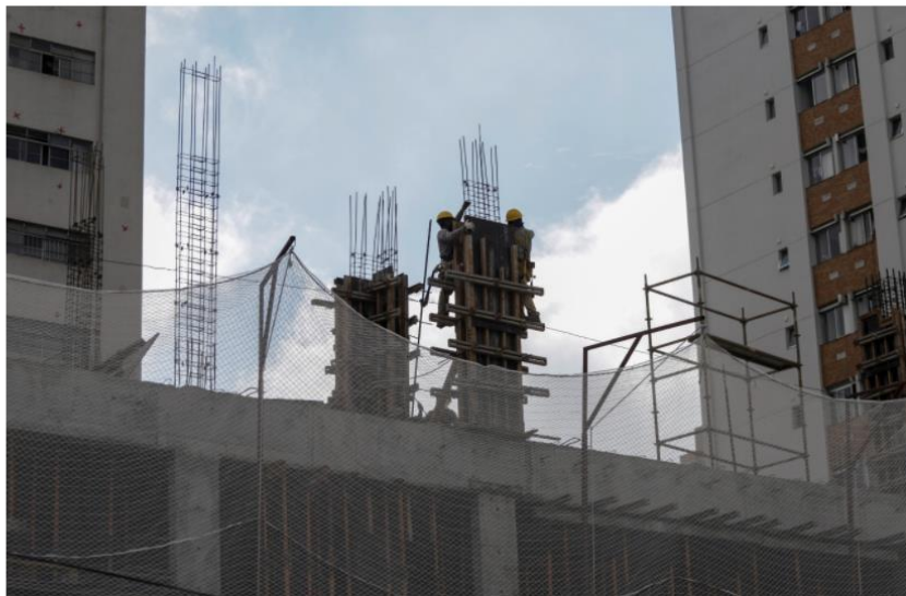
Edifício em construção
