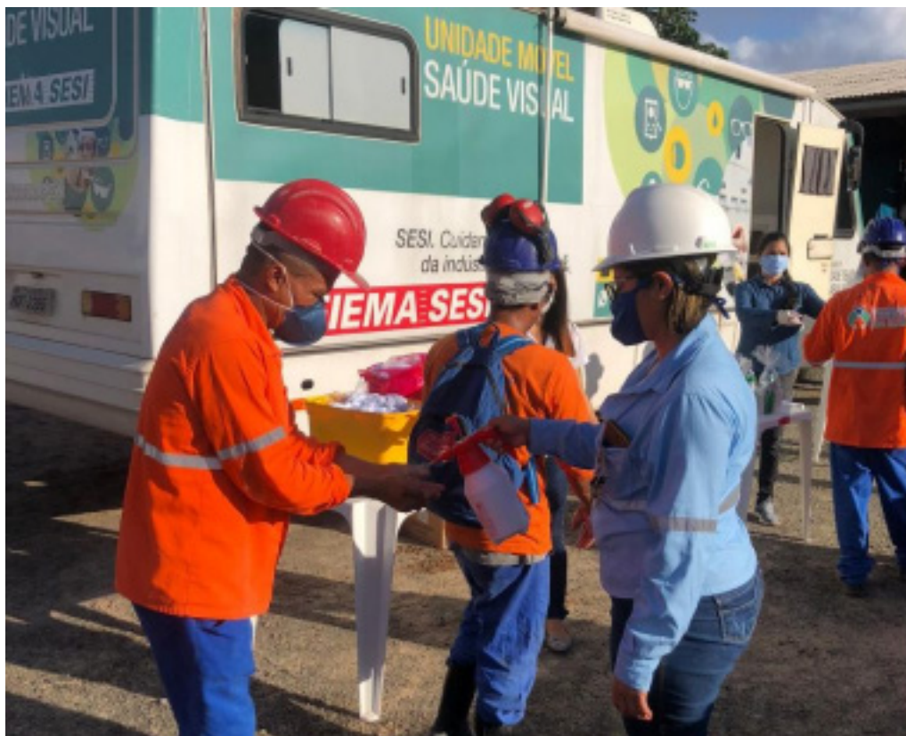
Higienização de funcionários no canteiro de obras
