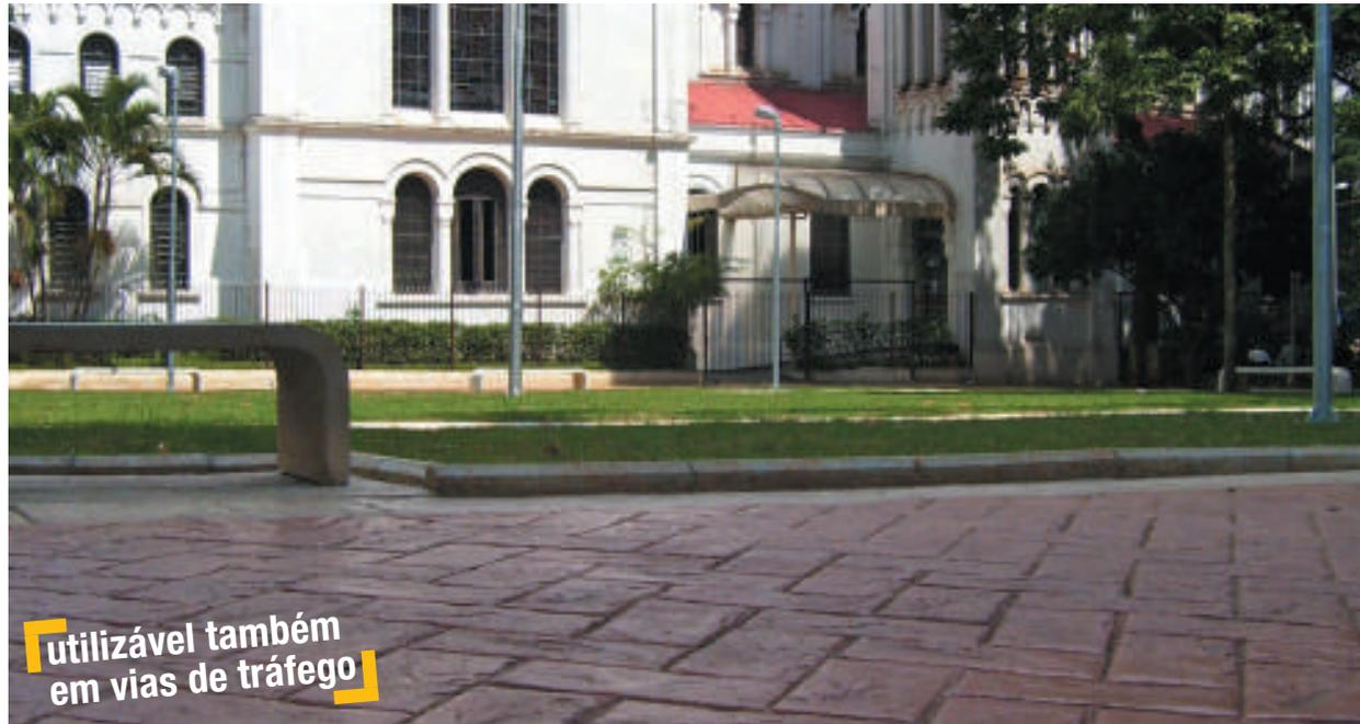
Se o objetivo é ter uma solução rápida para calçadas e também para vias urbanas, o piso em concreto estampado pode ser uma boa solução. Com o uso de ferramentas adequadas, fôrmas para estampagem e produtos de acabamento, ele é capaz de reproduzir cores e texturas variadas, surpreendendo pelos ótimos resultados.
