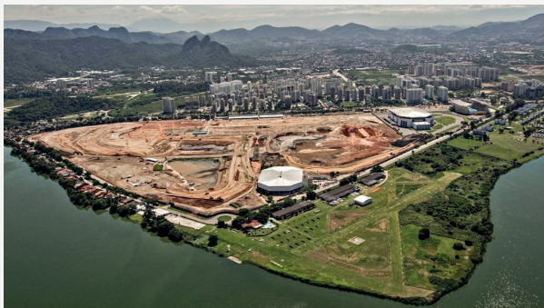
Obras do Parque Olímpico. Imagem extraída do Diário do Rio.
