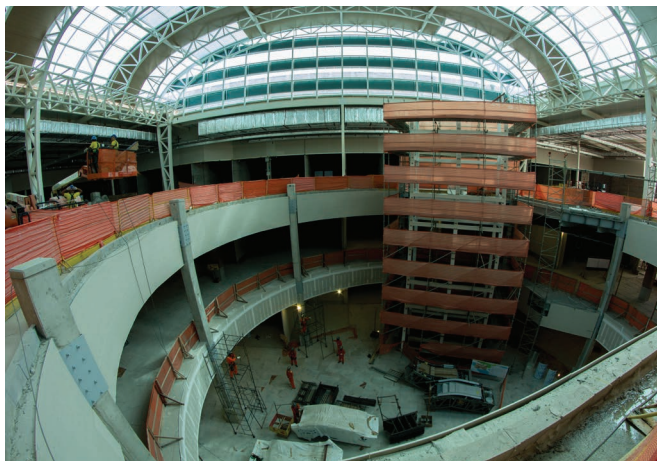
Obras do RioMar Recife, onde atuaram cerca de três mil trabalhadores da JCPM Empreendimentos
