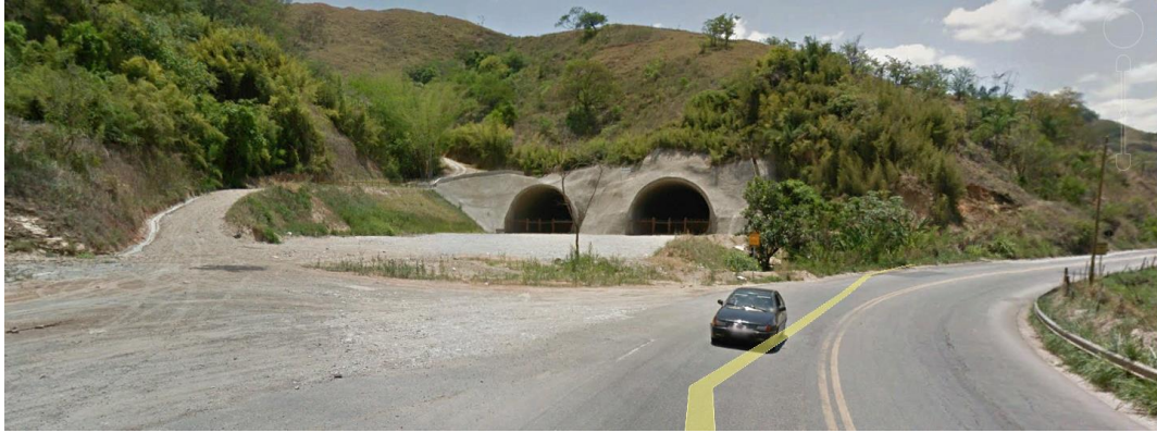
Figura 56 – Imagem em bocadura do túnel Piracicaba, Lote 3.2, CONSÓRCIO J. DANTAS – SOTEPA. (fonte: Googleearth, acesso: 03/05/2016).
