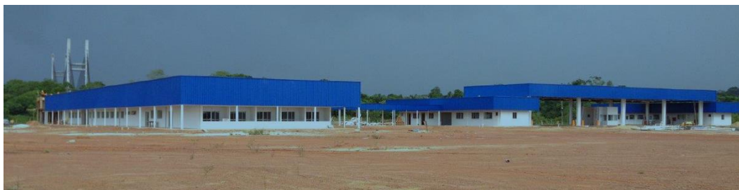
Figura 58 – Instalações de Fronteira - Aduana, Brasil e a Guiana Francesa, na BR-156/AP prontas em sem utilização. (fonte: Edital nº 557/2015-00, fl. 71).
