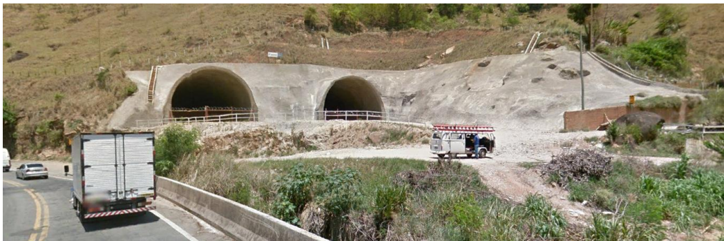
Figura 57 – Imagem da outra bocadura do túnel Piracicaba Lote 3.2, CONSÓRCIO J. DANTAS – SOTEPA. (fonte: Googleearth, acesso: 03/05/2016).
