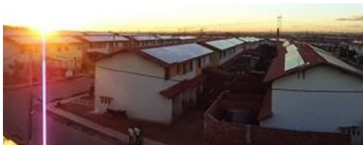
Figura 30 - Sistema de generación FV instalado en el condominio "Morada do Rodeadouro" y "Praia do Salitre"
