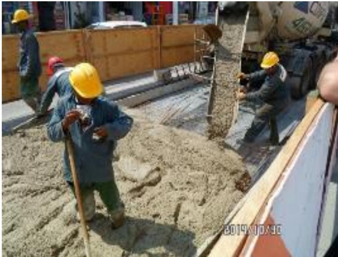
**Figura:** Concretagem de piso de concreto diretamente do caminhão.
