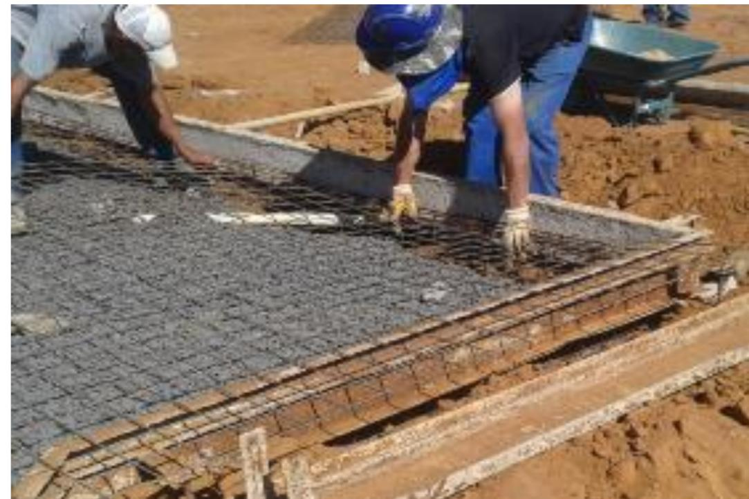
**Figura:** Fôrma metálica para radier.
