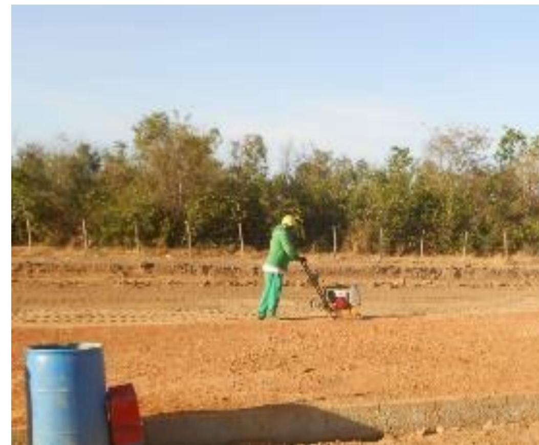
**Figura:** Compactação do solo com placa vibratória
