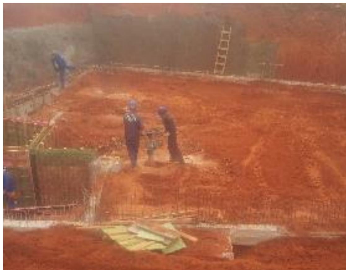
**Figura:** Compactação do solo com compactador a percussão
