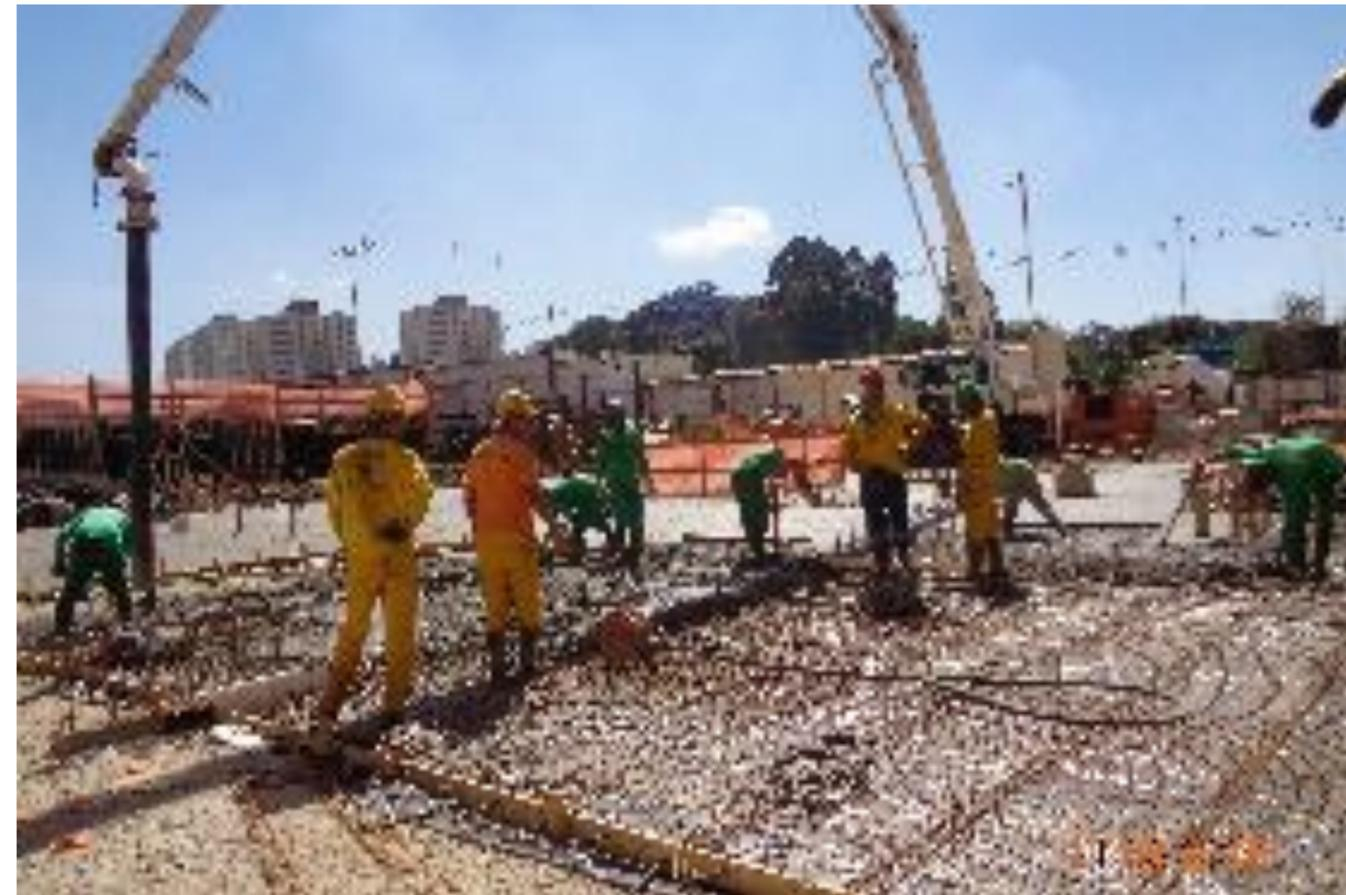
**Figura:** Concretagem de radier com bomba
