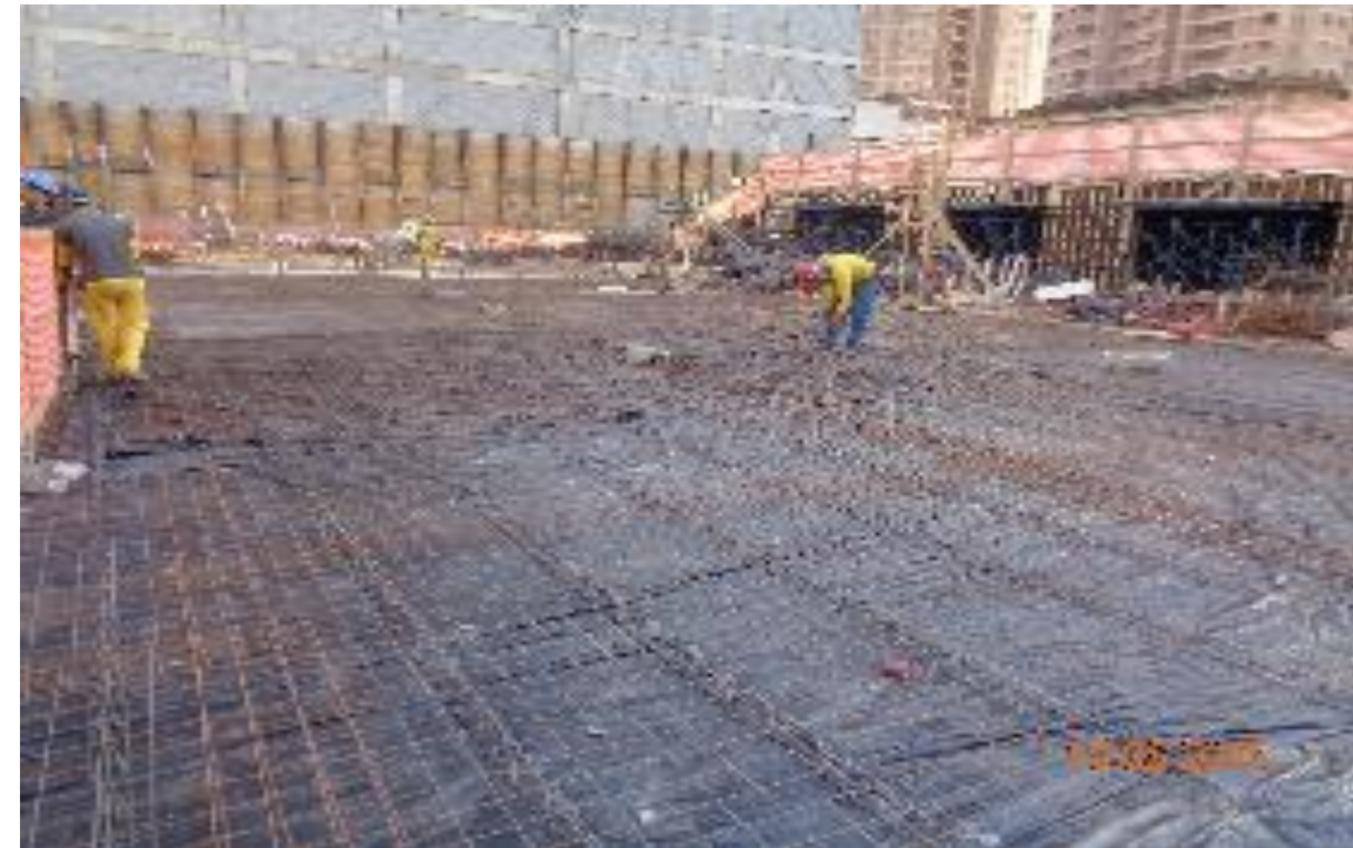
**Figura:** Armação de piso de concreto.
