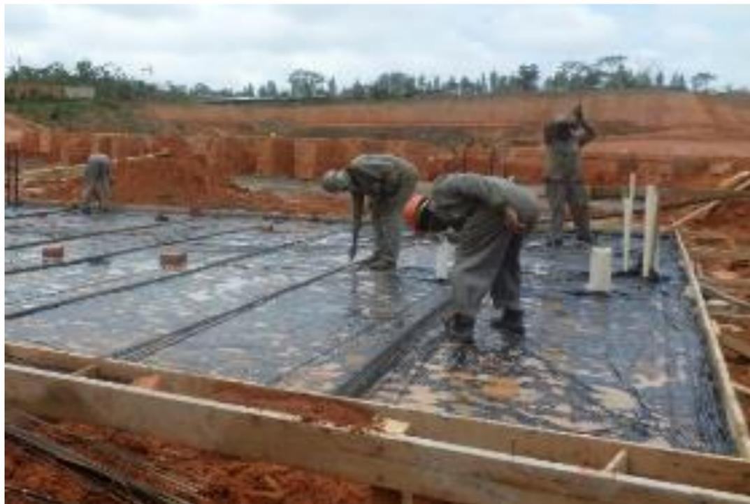
**Figura:** Fôrma de madeira serrada para radier.
