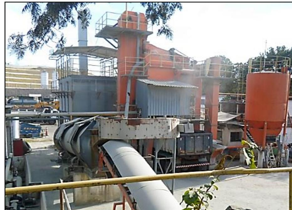
É enquadrado como **Usina de Asfalto** o conjunto de equipamentos mecânicos e eletrônicos interconectados, a fim de proporcionar, de forma adequada, a **mistura asfáltica** dentro dos parâmetros previstos em projeto.
