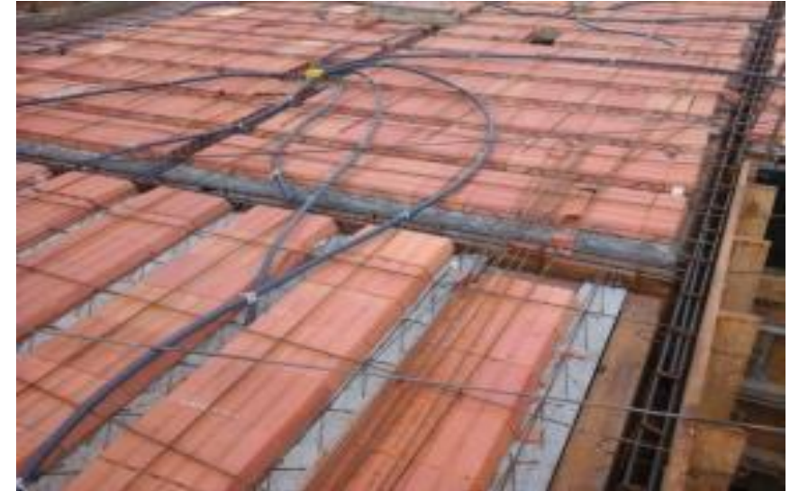
Lajotas cerâmicas e vigotas treliçadas
