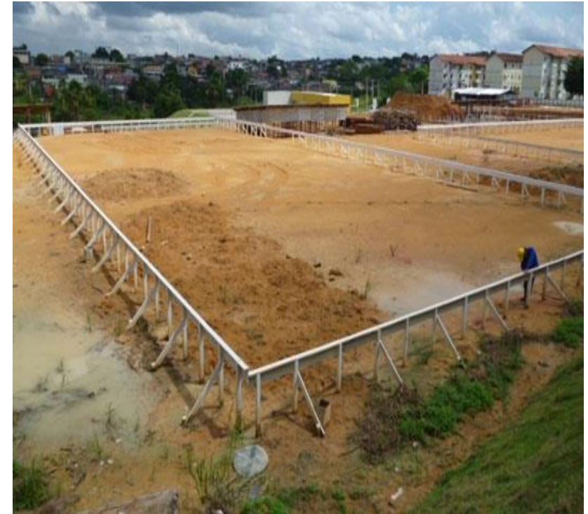
Obra utilizando gabarito de tábuas corridas
