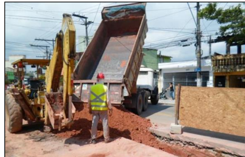
Reaterro com troca de solo
