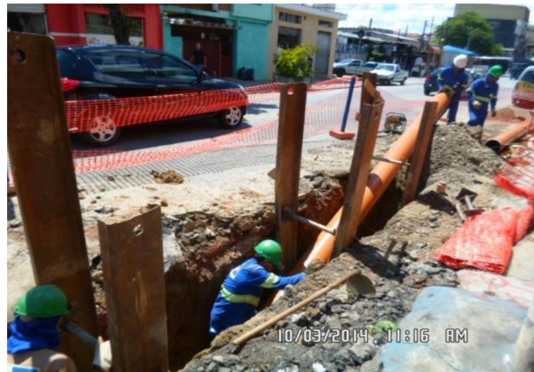
Assentamento manual de tubo de PVC
