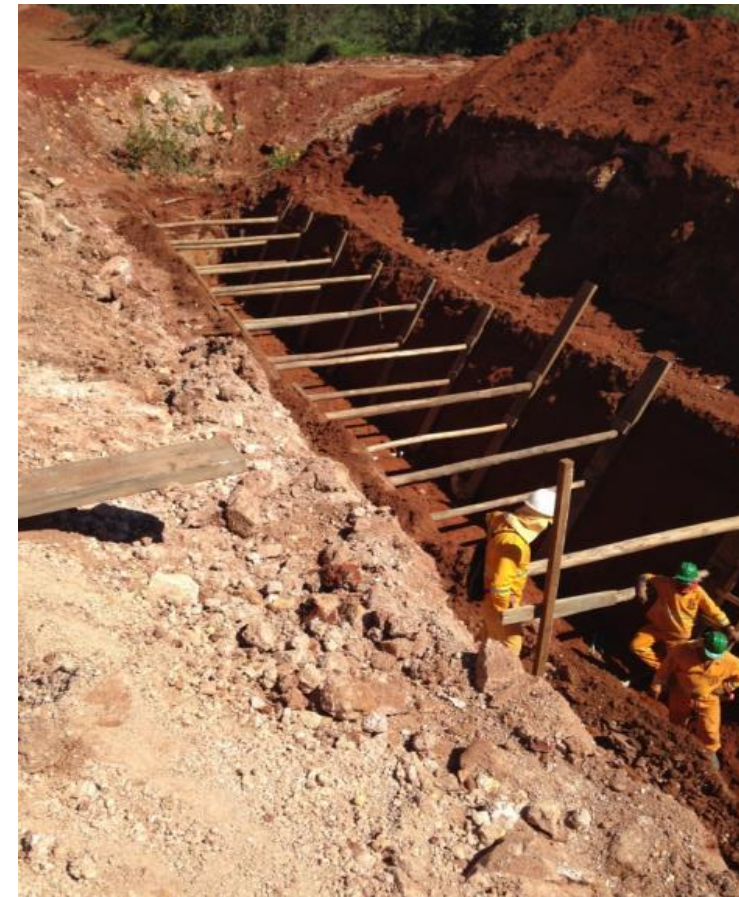
Escoramento tipo pontaleamento
