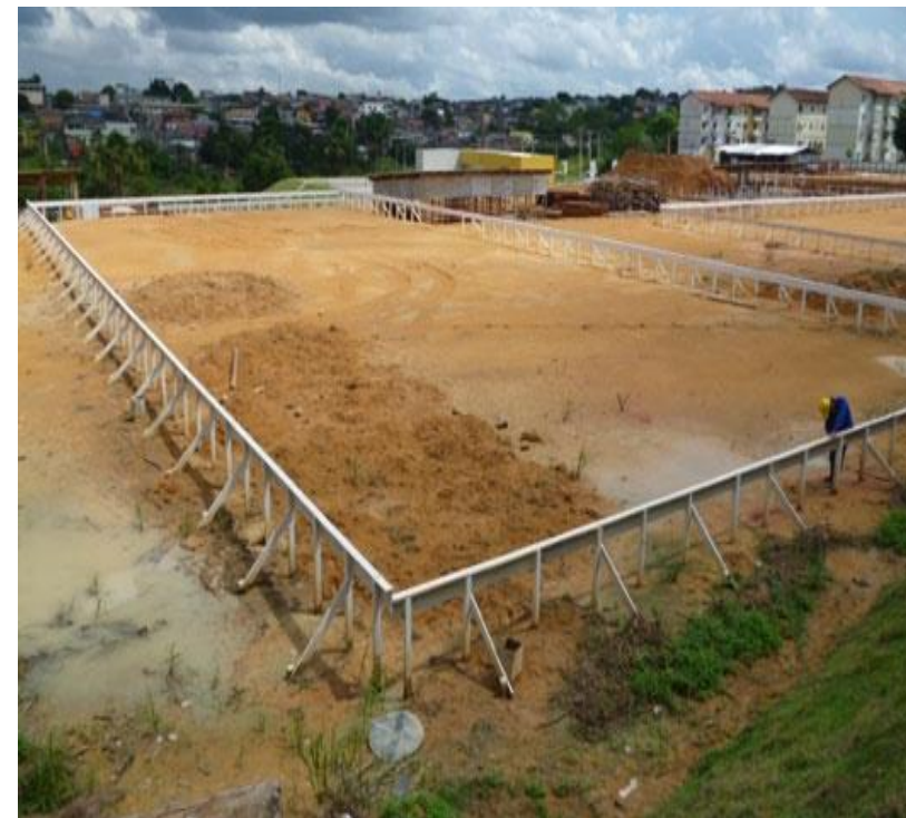
Obra utilizando gabarito de tábuas corridas
