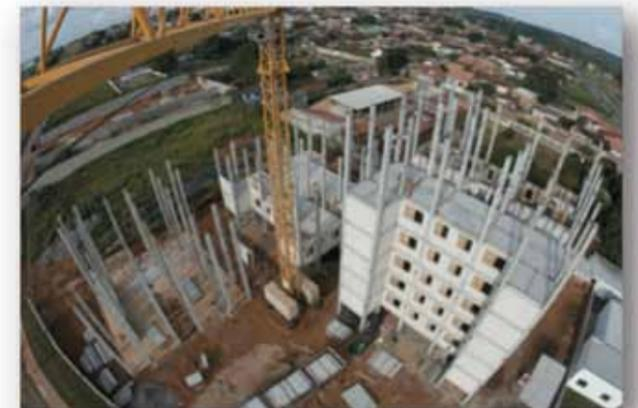
**Foto 7** • Peças estruturais chegam ao canteiro furadas e com pintura de fundo
