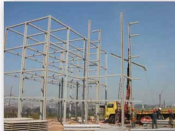
**Foto 9** • A estrutura de aço é montada em 7 dias
